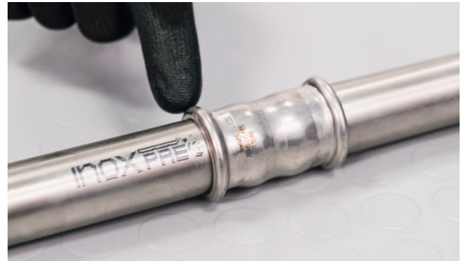
Bild 34 – Kontrolle der Pressverbindung
