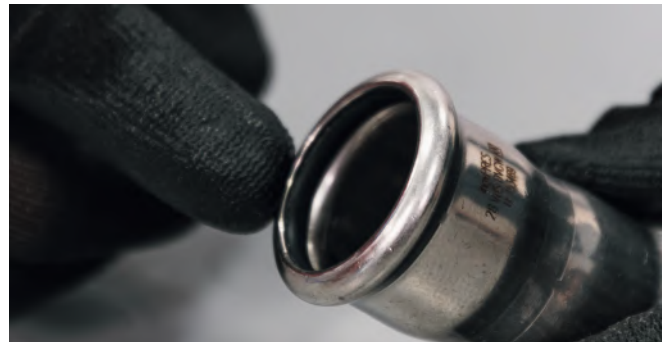
Bild 31 - Überprüfung Dichtring
