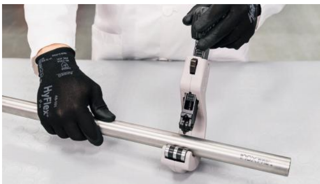
Bild 26 - Ablängen des Leitungsrohres
